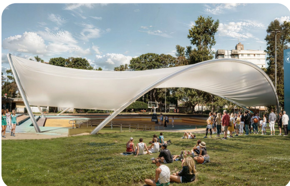
Cubierta Paseo XXI (Rosario)
