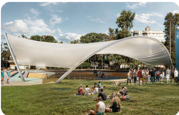
Cubierta Paseo XXI (Rosario)
