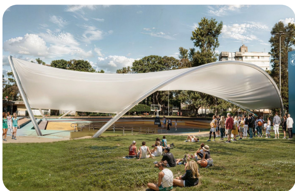
Cubierta Paseo XXI (Rosario)
